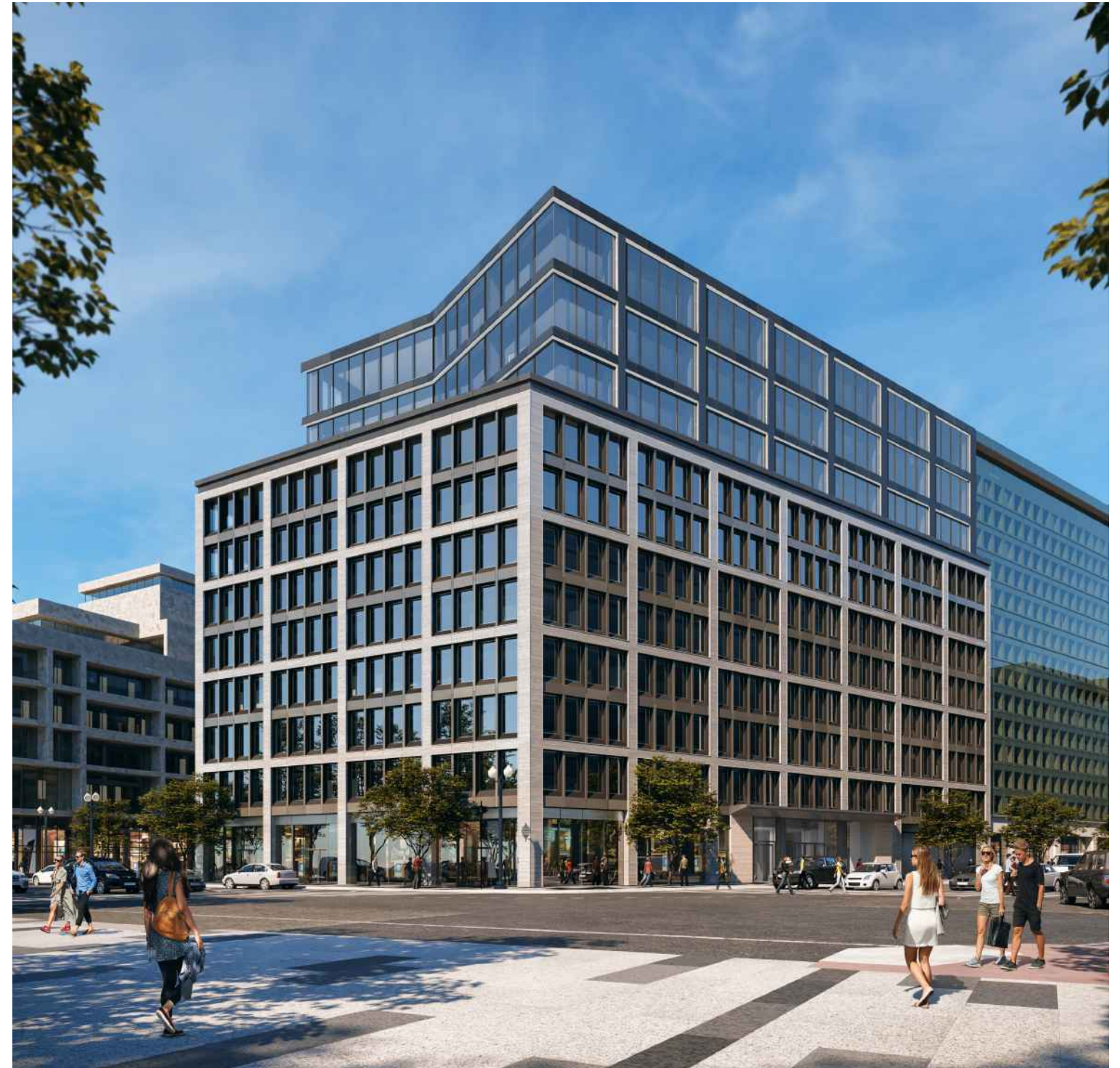
NE Corner, Penn Ave
